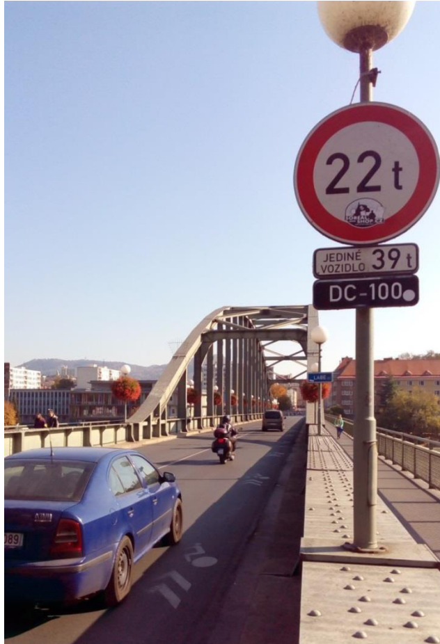
Obrázek 22 Tyršův most v současném stavu (zdroj: RHDHV)
