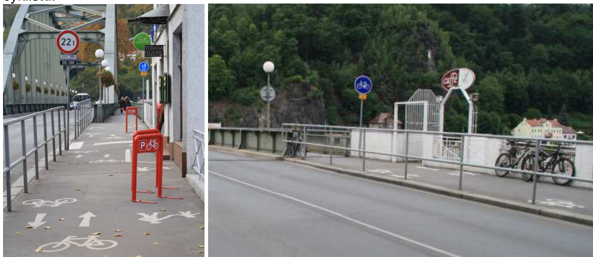
Stojany v profilu stezky pro chodce a cyklisty nejsou vhodně umístěny, avšak jejich smyslem je ochrana východů z objektu. Podél stezky je zábradlí - návštěvníci mohou kola uzamknout k zábradlí.
