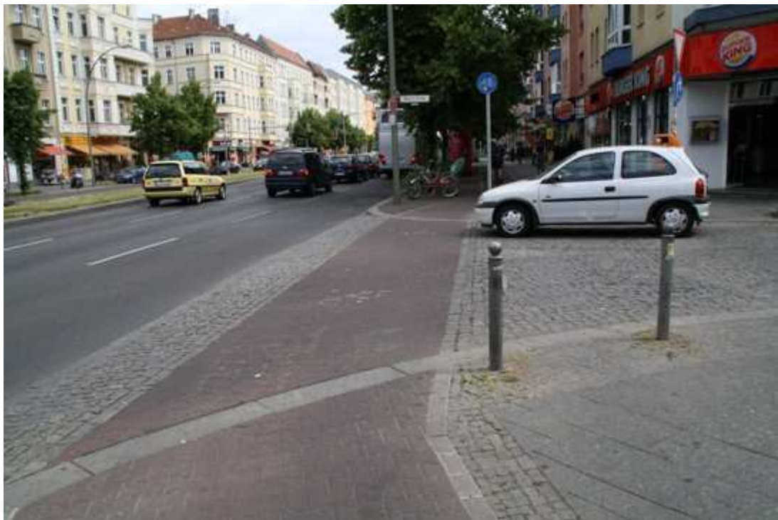
ilustrační foto – křížení pásů pro cyklisty s vedlejšími komunikacemi, které jsou ve zklidněném režimu (např. zóna 30, resp. obytná či pěší zóna) je vhodné řešit jako nadřazené, tj. stavebně i opticky jako primární směr, který je křížován (Německo, Berlín)
