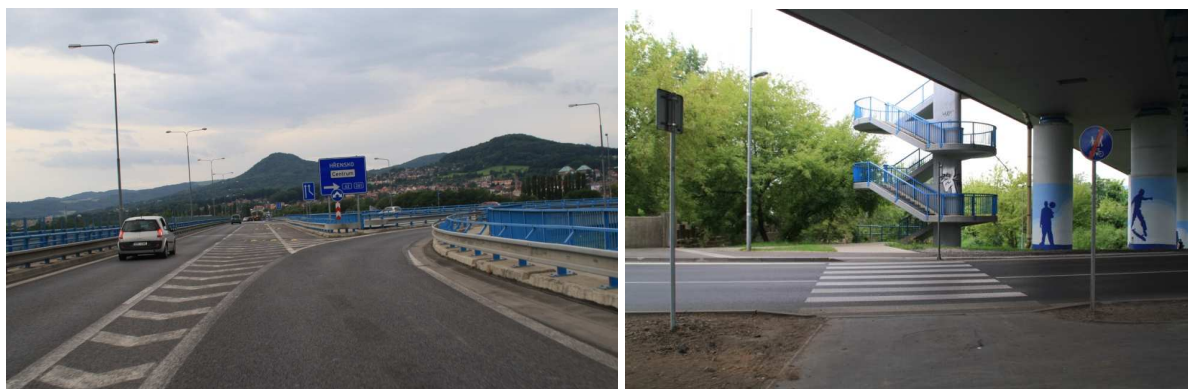
Zásadní bariérou pro cyklodopravu je Nový most na silnici I/13
