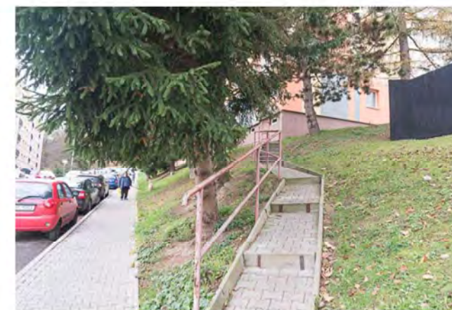
schodiště k panelovému domu Na Vyhliďce
