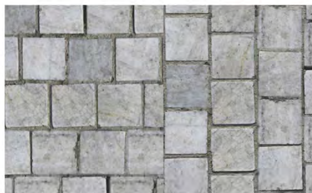
betonová dlažba s reliéfním povrchem, ostařená, položená ve dvou směrech
