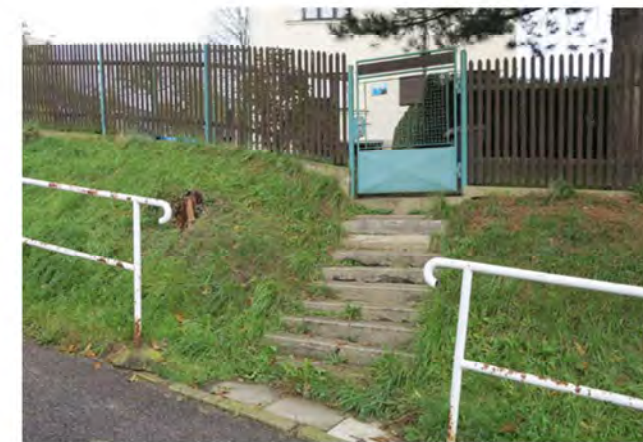
zábradlí v Kyjevské ulici
