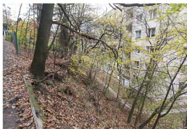
panelový dům pod Lesní cestou
