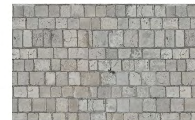
kamenná dlažba na náměstí, drobná, řezaná
